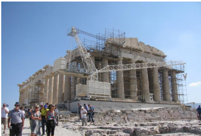
Überall wird eifrig restauriert, auch mit Kränen
