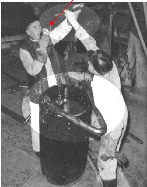
2 Lote im Wasserbehälter (dämpft die Schwingungen)
